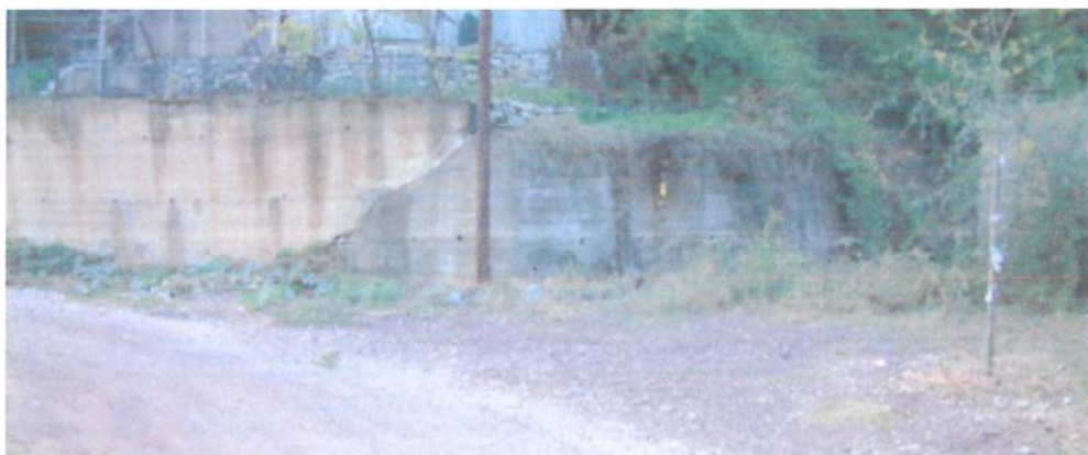
Η σχέση του πλατώματος με τον διαμορφωμένο δρόμο και οι τοίχοι αντιστήριξης
